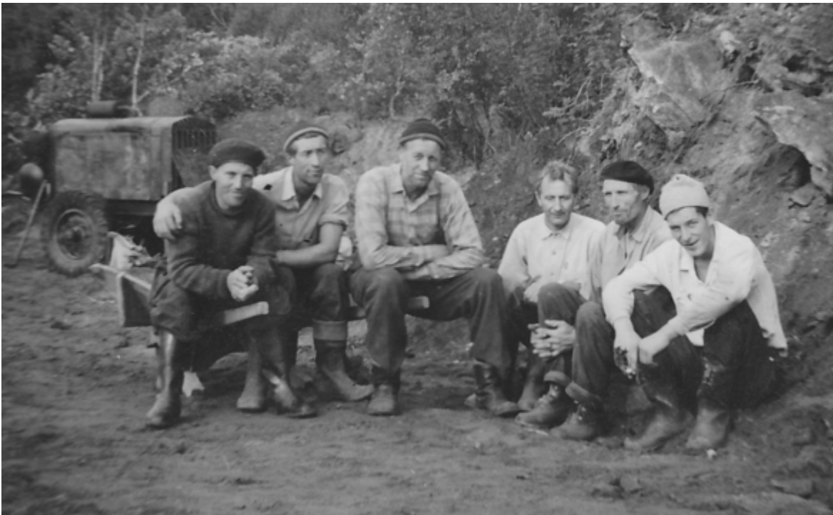
Arbeidslag på Ågdalsveien 1957 (Birger Ingebrigtsens samling)
